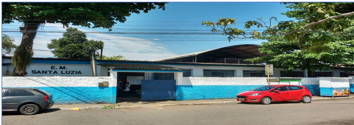
Figura 2- Vista de frente da Escola Municipal Santa Luzia.
